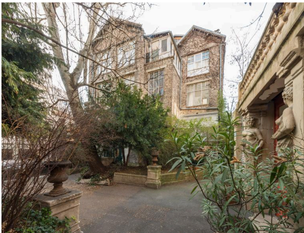
Vue de la façade du bâtiment Fernand Léger depuis l'entrée de La Ruche
