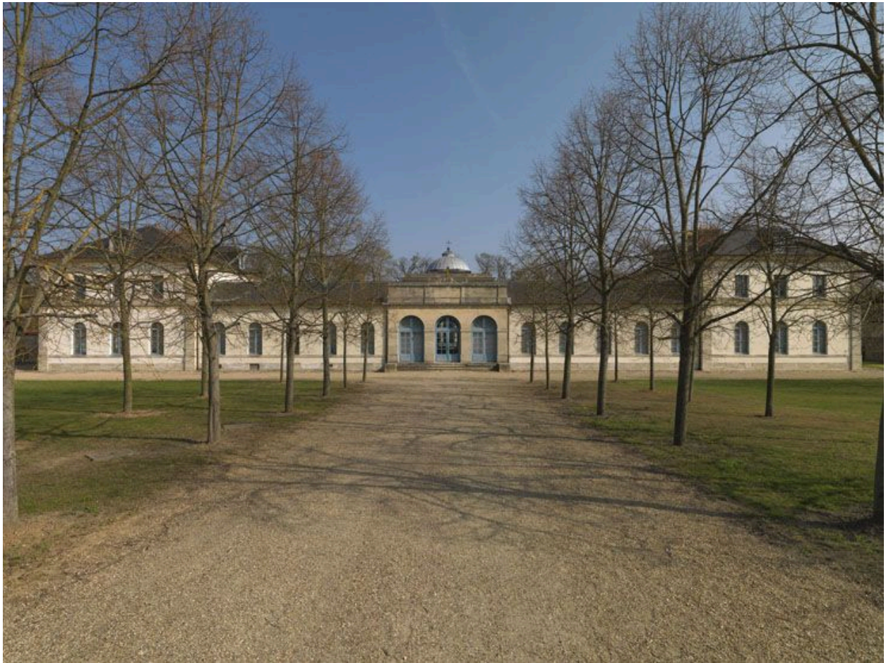
Vue d'ensemble de la façade d'entrée.
