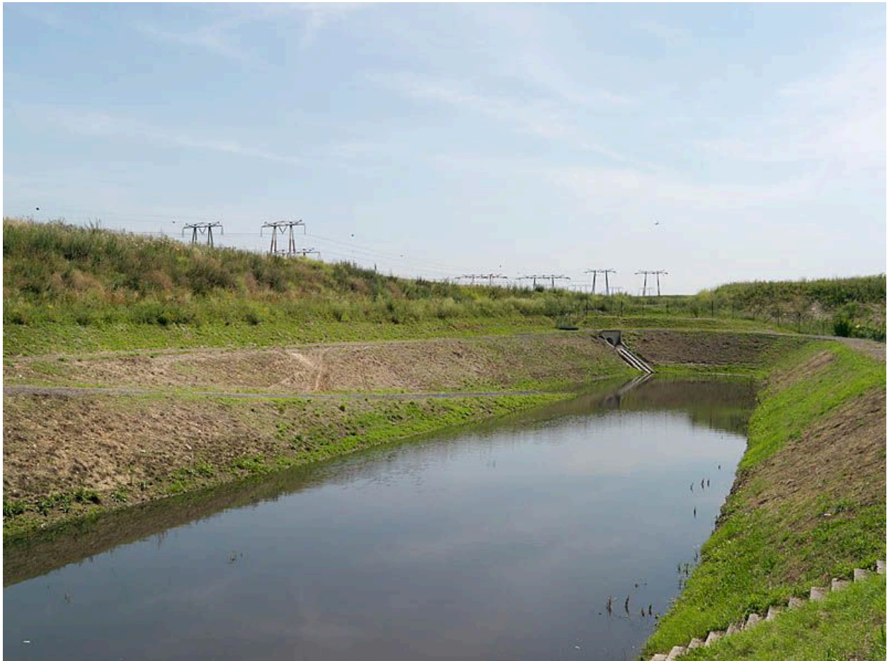
95, Le Thillay, Gonesse. Retenue d'eau.
