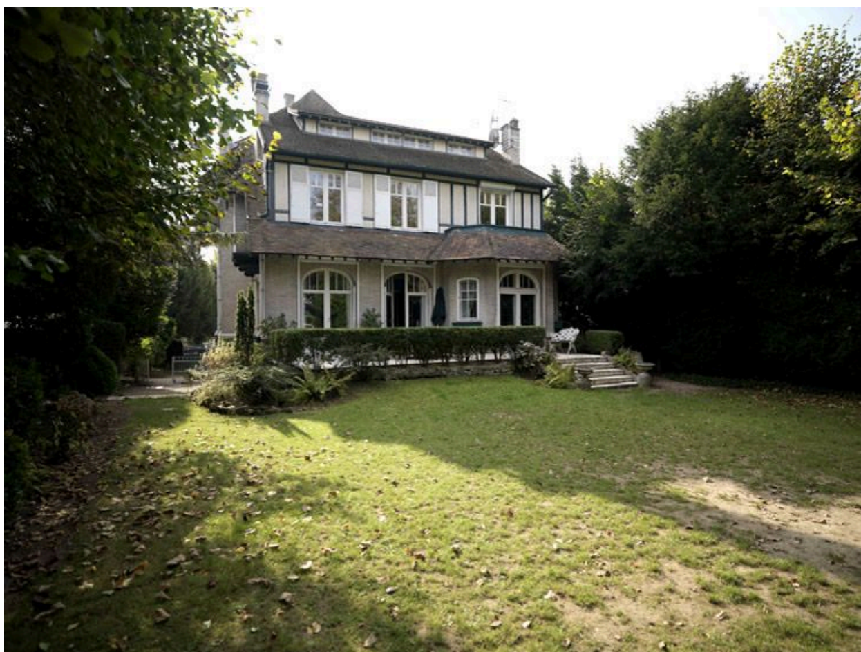
Vue d'ensemble, depuis le jardin.
