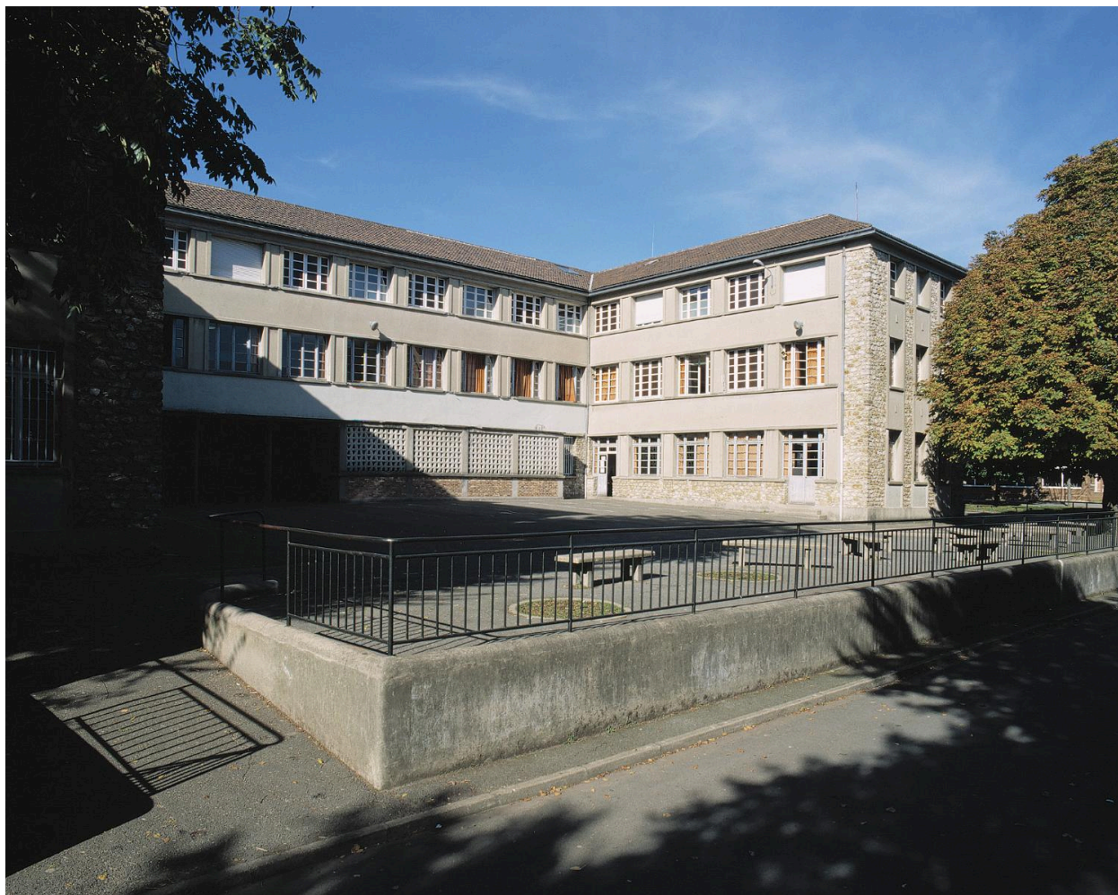
Façade postérieure du bâtiment scolaire construit en 1950.
