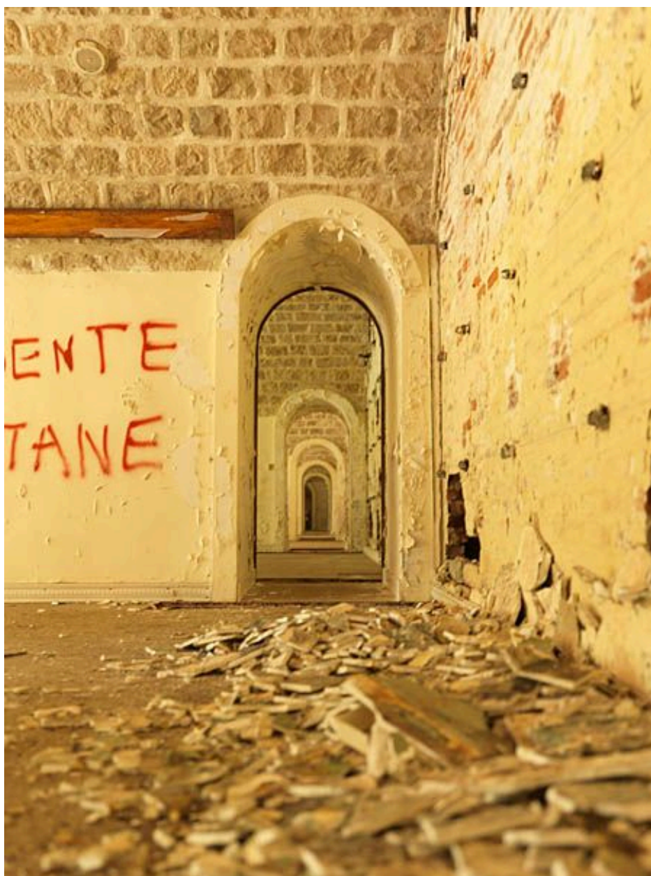
Vue intérieure de l'enfilade des portes communicantes entre les casemates de la batterie sud.
