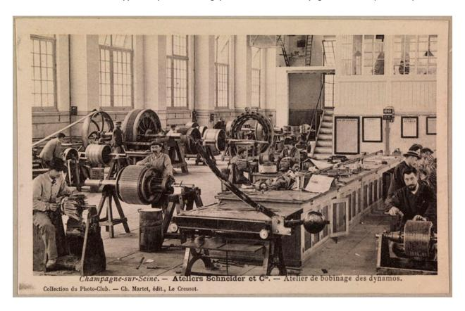
Carte postale ancienne, avant 1914. Atelier de bobinage des dynamos. la pose des bobines est réservée aux hommes.
