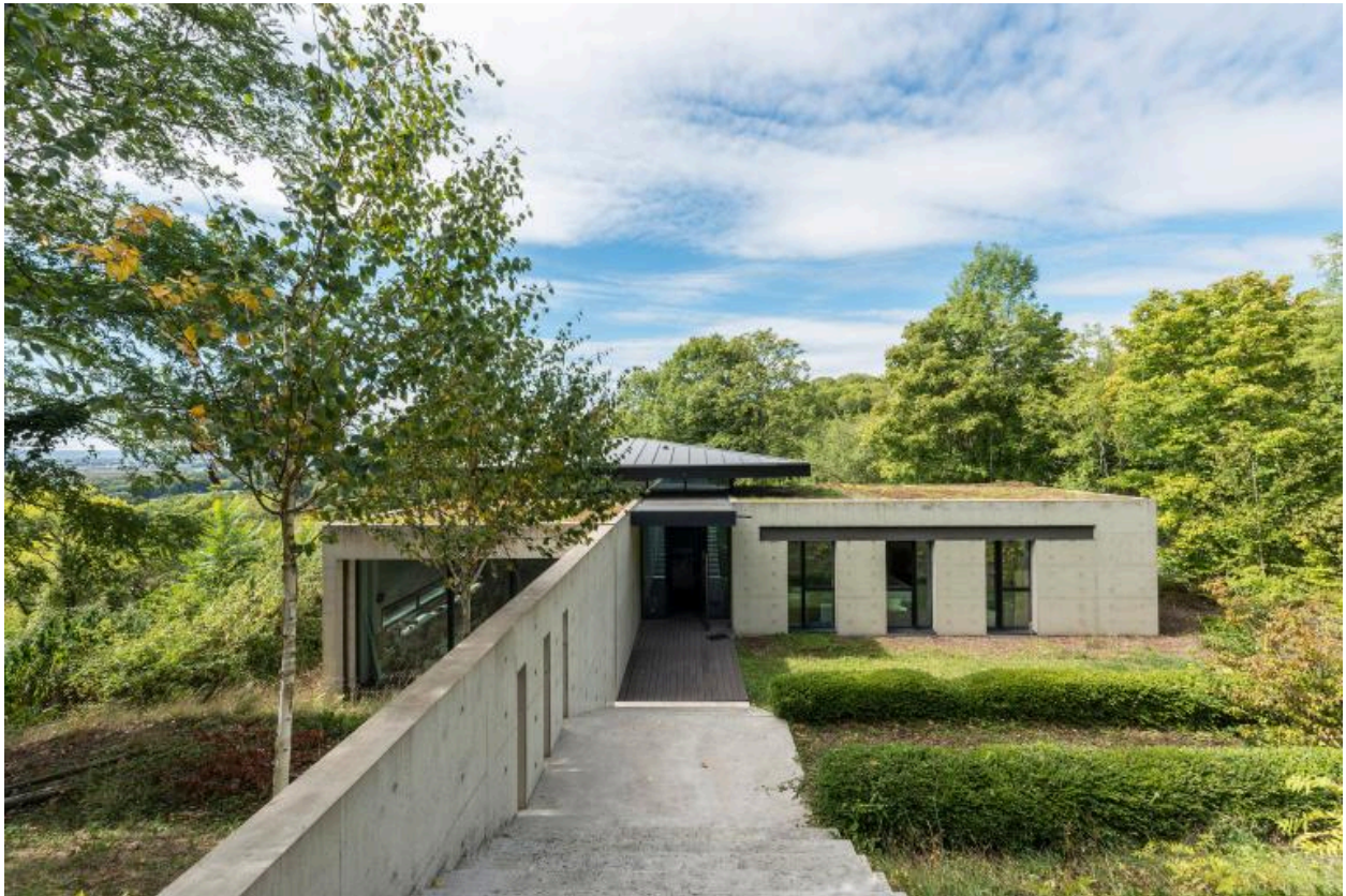
Voie d'accès à l'atelier
