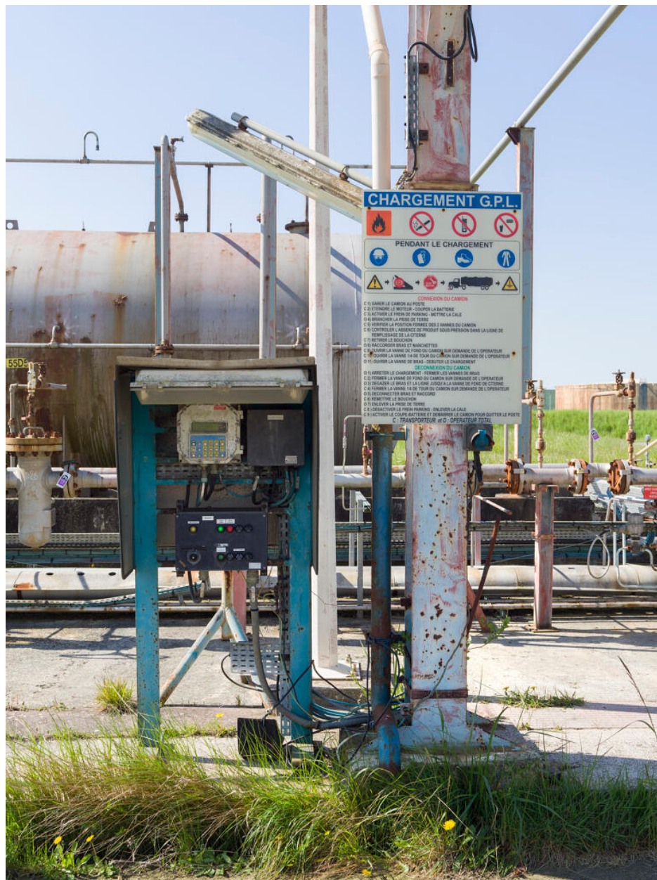
Zone de chargement GPL (Unité 550). Quai de chargement GPL. Le panneau à droite indique le mode opératoire du chargement. À gauche, le compteur volumétrique.
