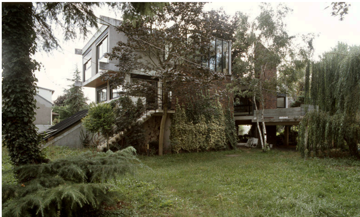
Maison, 17 quai d'Artois. Vue d'ensemble latérale.
