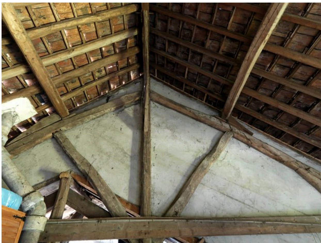
Charpente de l'atelier.
