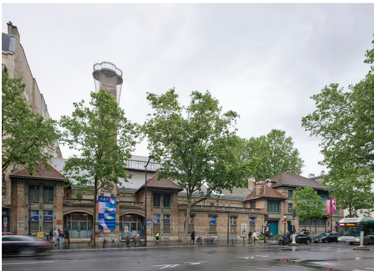
Le gymnase Jean Jaurès. Façade sur l'avenue Jean-Jaurès.
