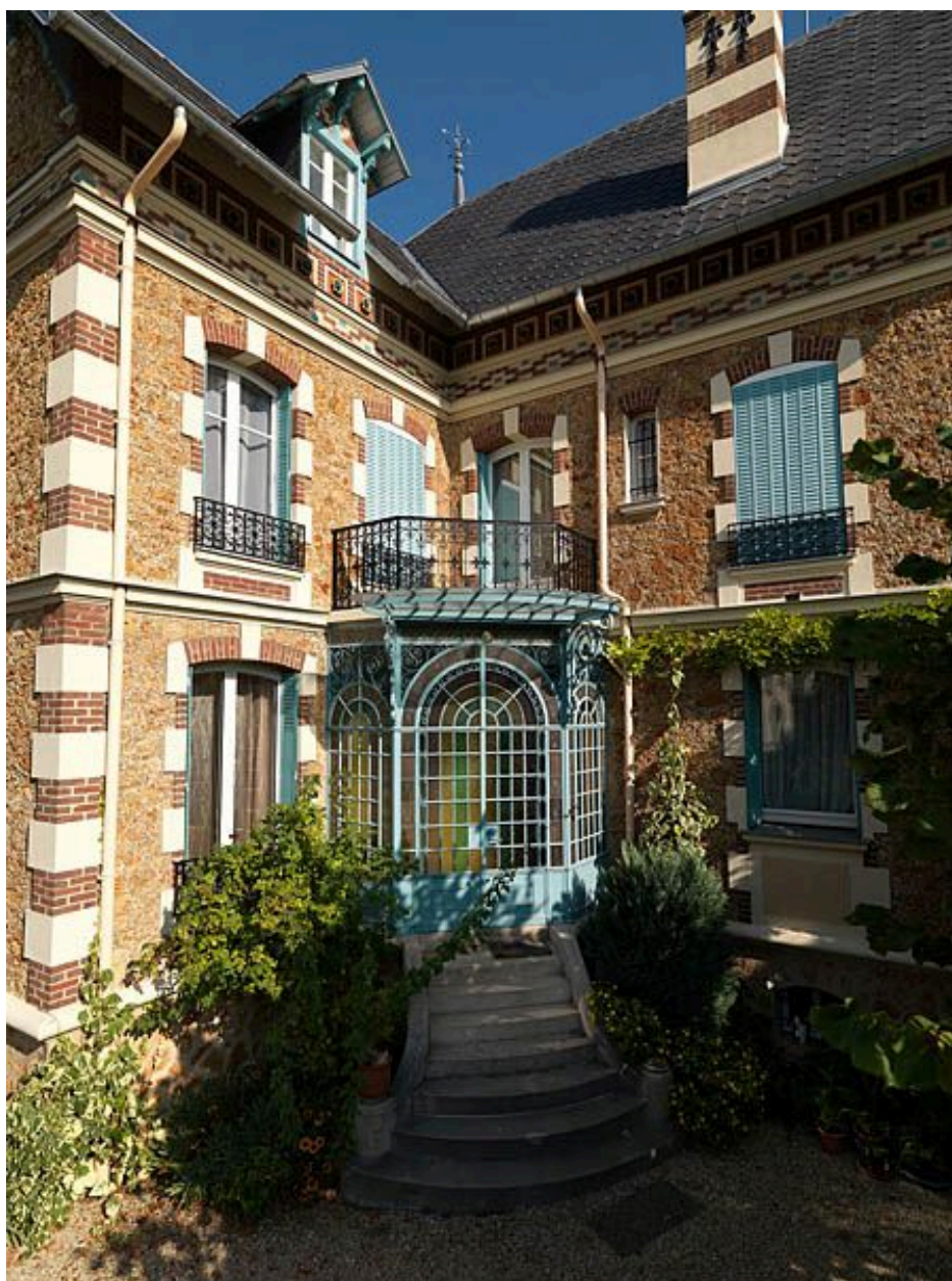
Détail de la façade.
