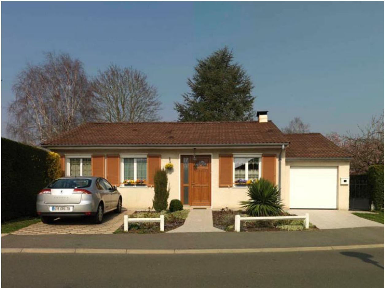
Maison de type "Villandry", avec le garage rejeté latéralement.
