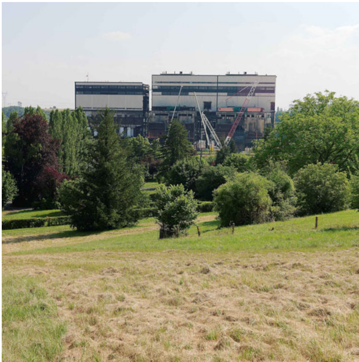
Chantier de démolition de la centrale.
