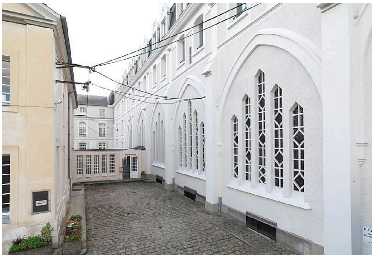
Couloir reliant l'ancienne chapelle à la nouvelle.
