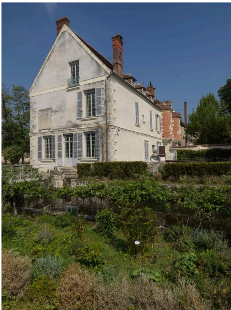
Vue du bâtiment principal (1)
