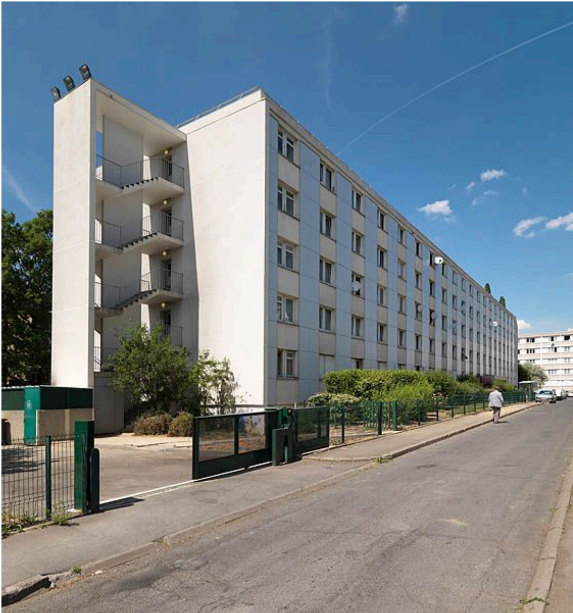
Cité dite Résidence Saint-Hubert. Vue générale du foyer de travailleurs depuis l'escalier extérieur sud. La rénovation a inclu un travail de résidentialisation du bâtiment.
