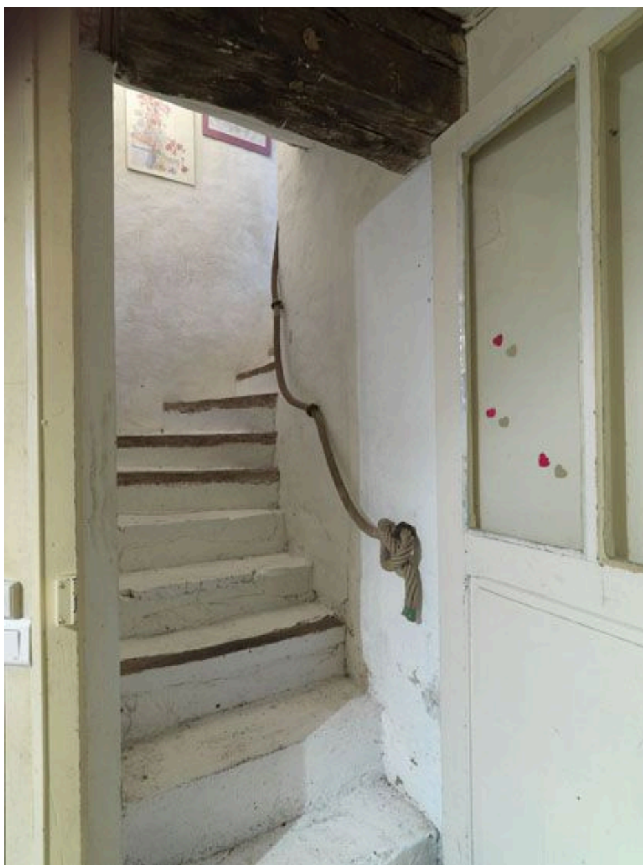
Escalier entre deux murs conduisant à l'étage de la maison à gauche de la cour.
