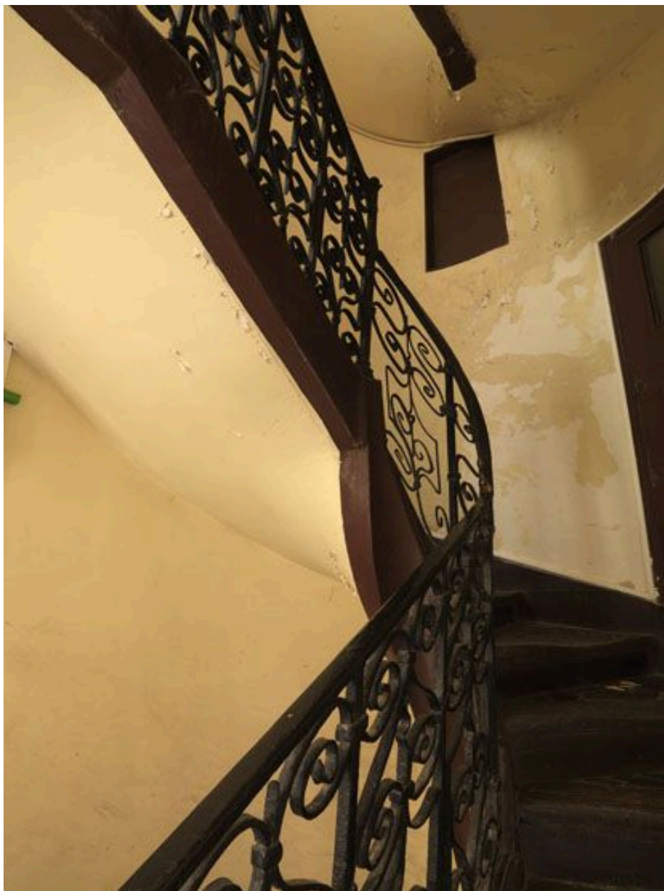
Partie tournante de l'escalier.
