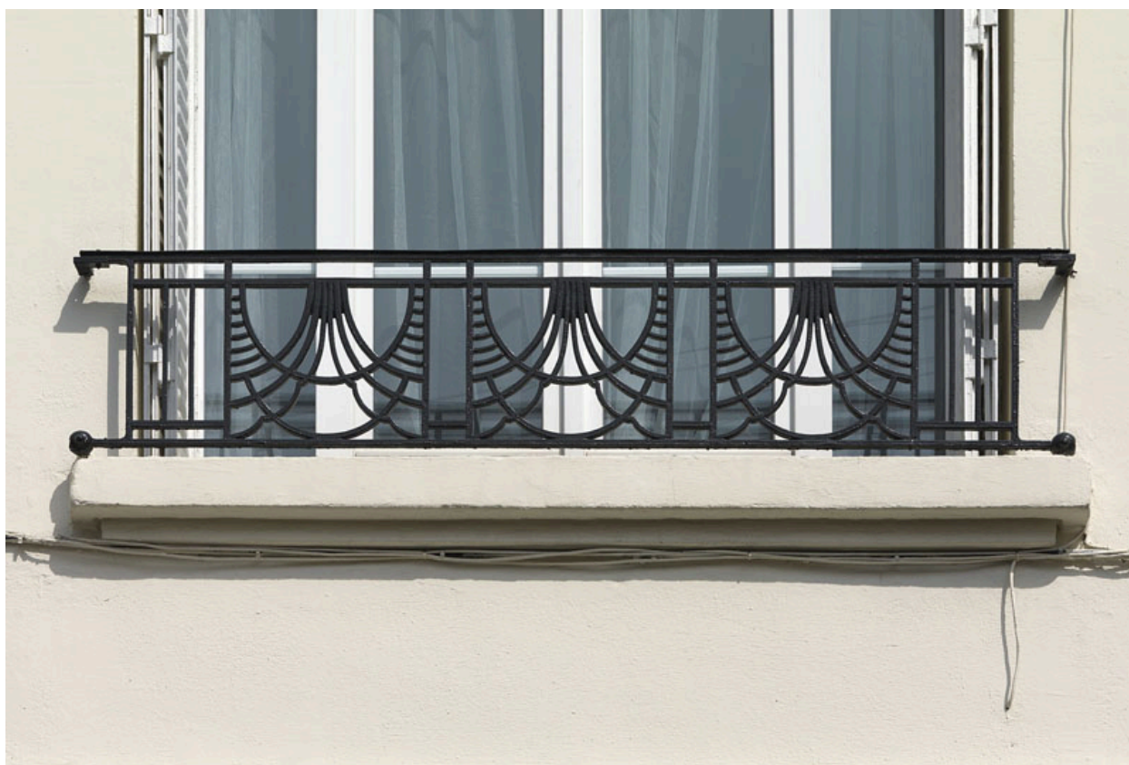
Détail de l'un des garde-corps en ferronnerie.
