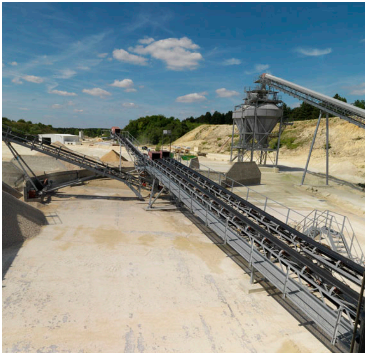
Plateforme - installation secondaire.
