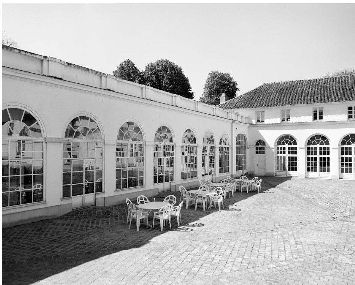
La façade de l'orangerie sur la cour des écuries.
