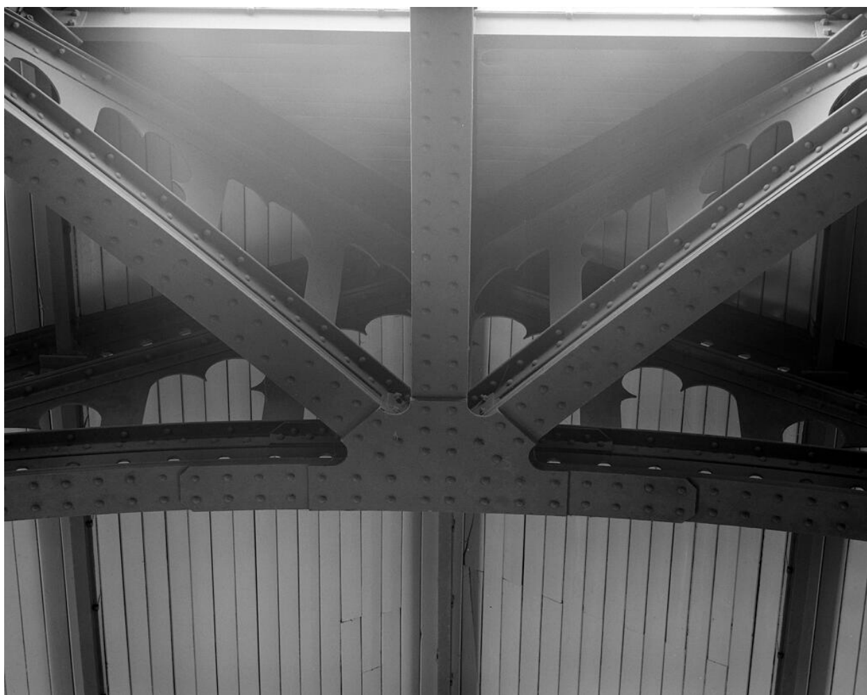
Gymnase. Détail de charpente de la dernière travée vue du côté opposé à l'entrée. Lycée dit Lycée Lakanal
