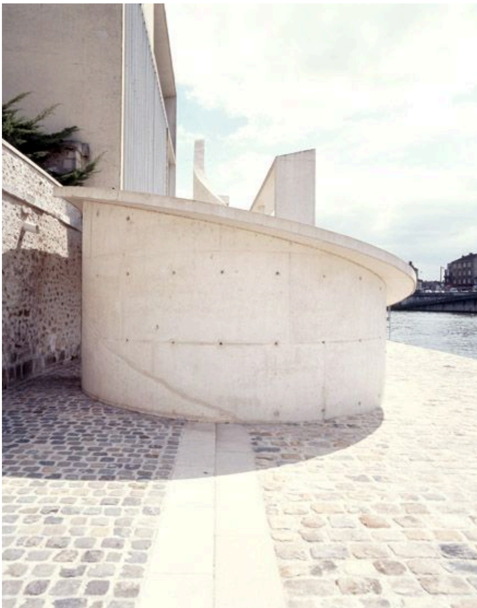
La rampe d'accès à la terrasse, sur le quai de la Reine-Blanche, vue depuis l'ouest.
