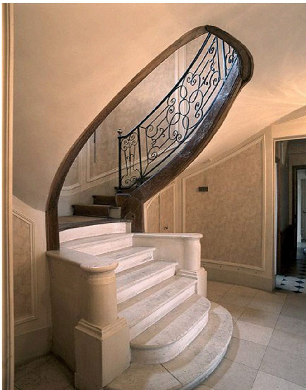
La volée droite et le garde-corps de la volée en fer à cheval.
