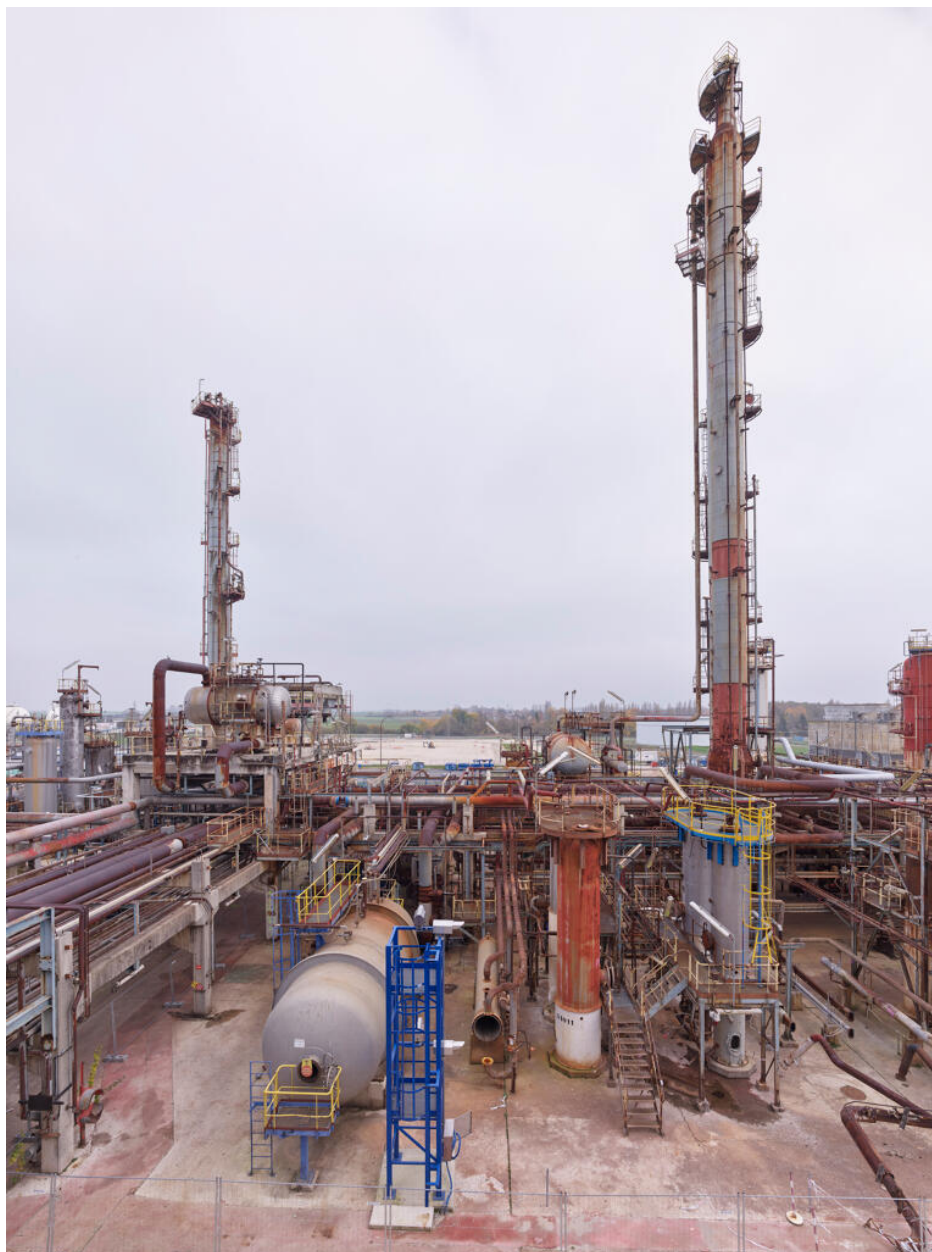
Unités Est - Zone FCC (Unité 651). Vue partielle sur l'alkylation. La structure en bleu est le radar de détection de fuite d'acide fluoridrique (HF).
