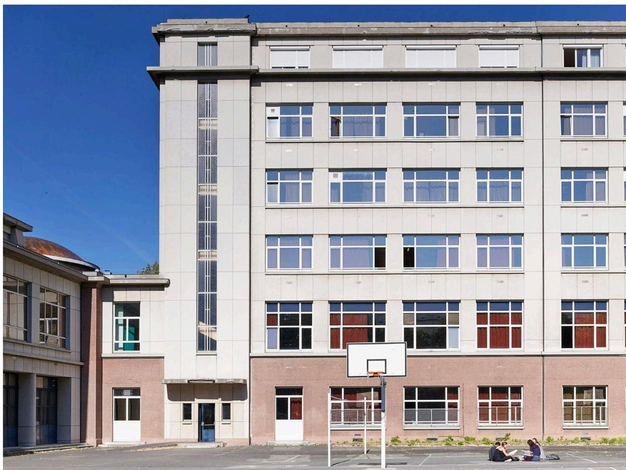
Les élévations se caractérisent par un parement de panneaux de mignonette grise. Le calepinage de ces panneaux forme une grille de composition qui scande les façades, créant un rythme visuel.
