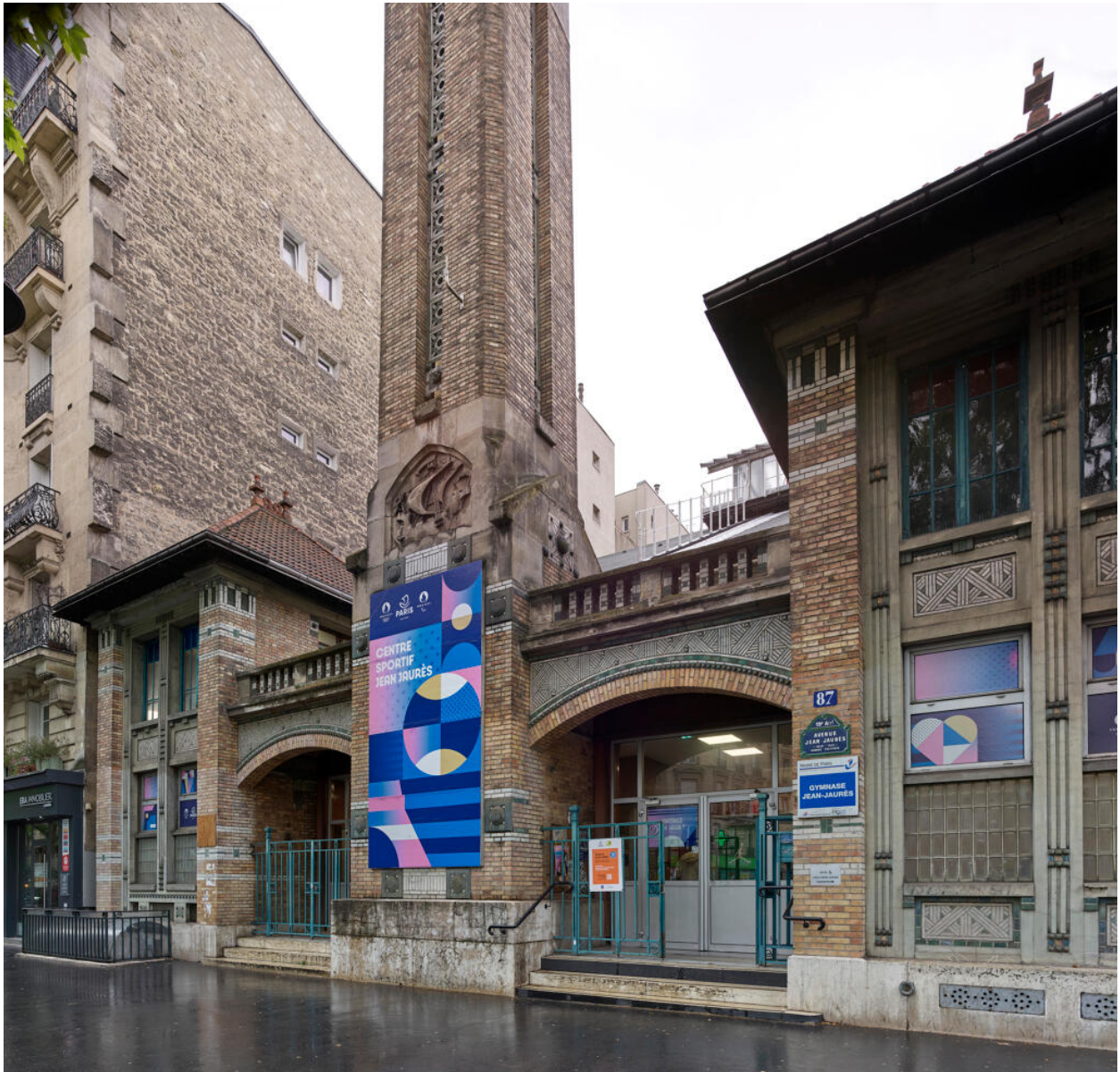
Le gymnase Jean Jaurès. Entrée principale et son beffroi.
