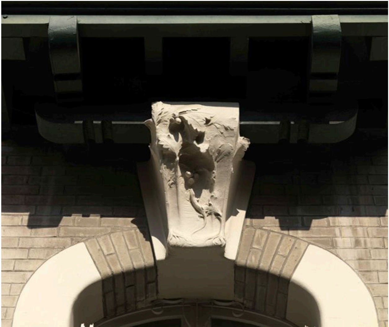
Détail de la façade : motif sculpté à la clé de la fenêtre du rez-de-chaussée.
