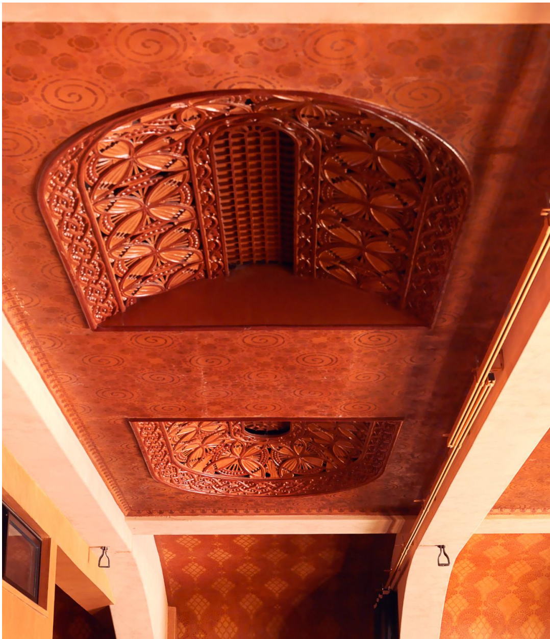
Caissons ornés du plafond du balcon
