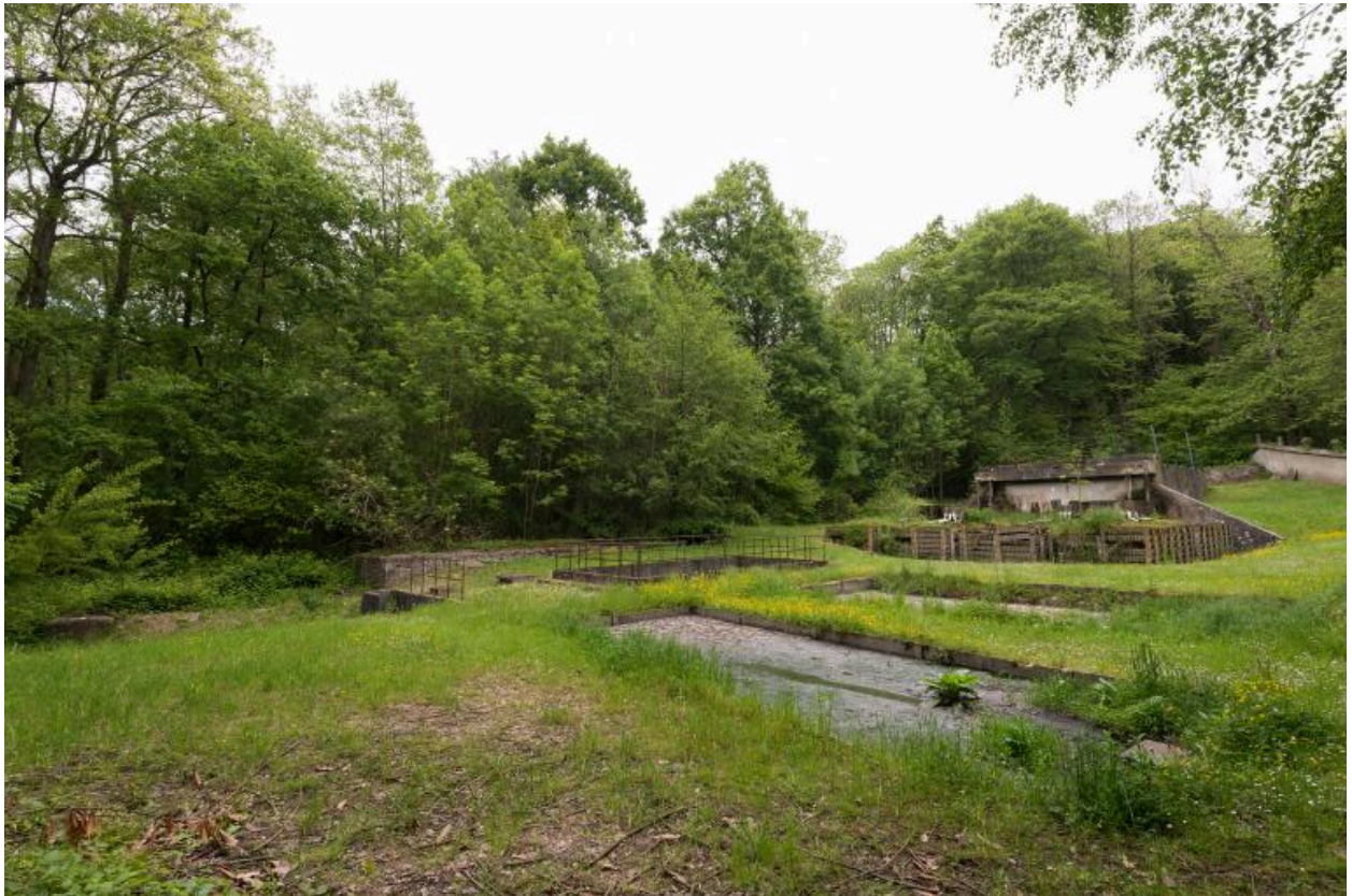
Vue générale du bassin d'épuration
