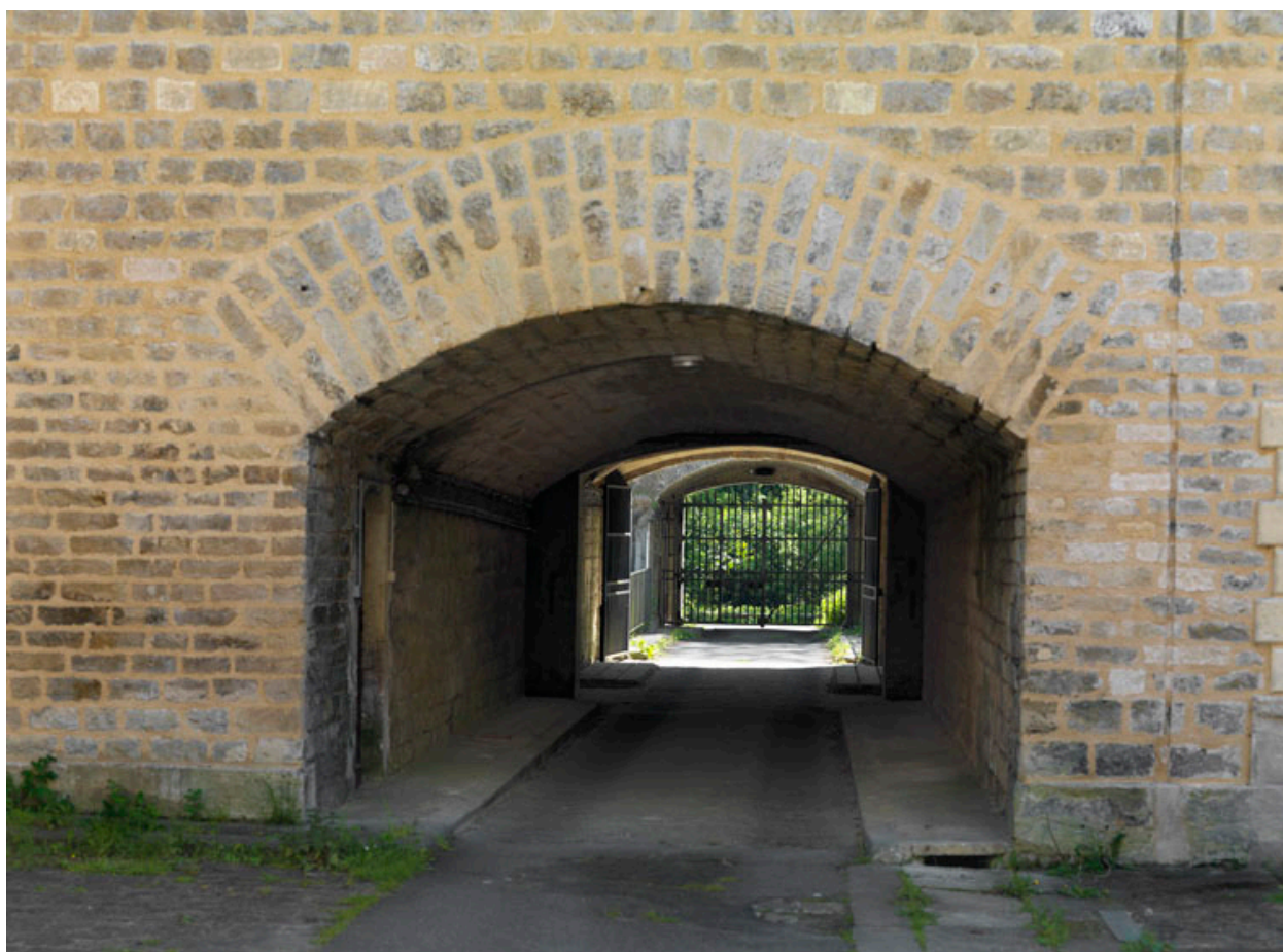
L'entrée du rempart, côté nord. Vue prise depuis la cour de la caserne.
