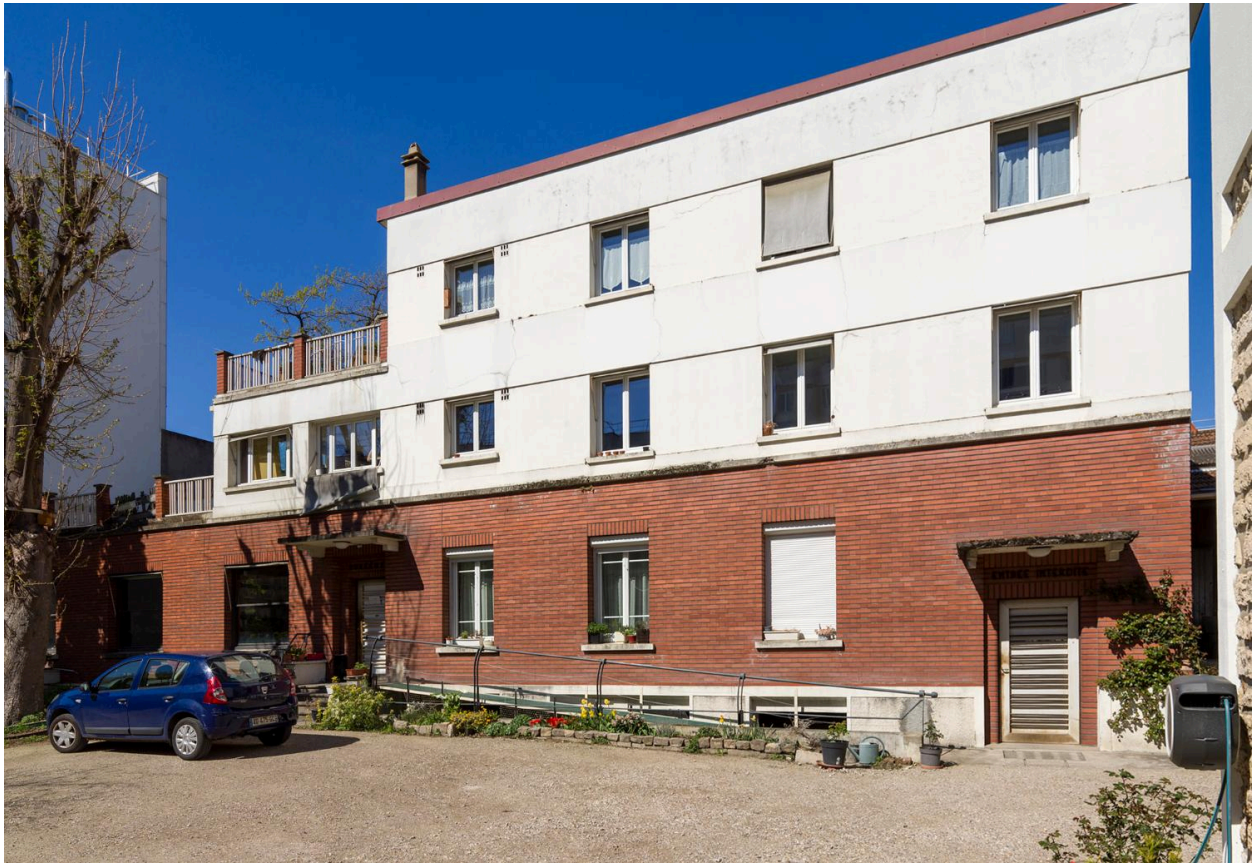
Vue extérieure des Ateliers de Technochimie, depuis la cour. Les bureaux et le pavillon d'habitation.
