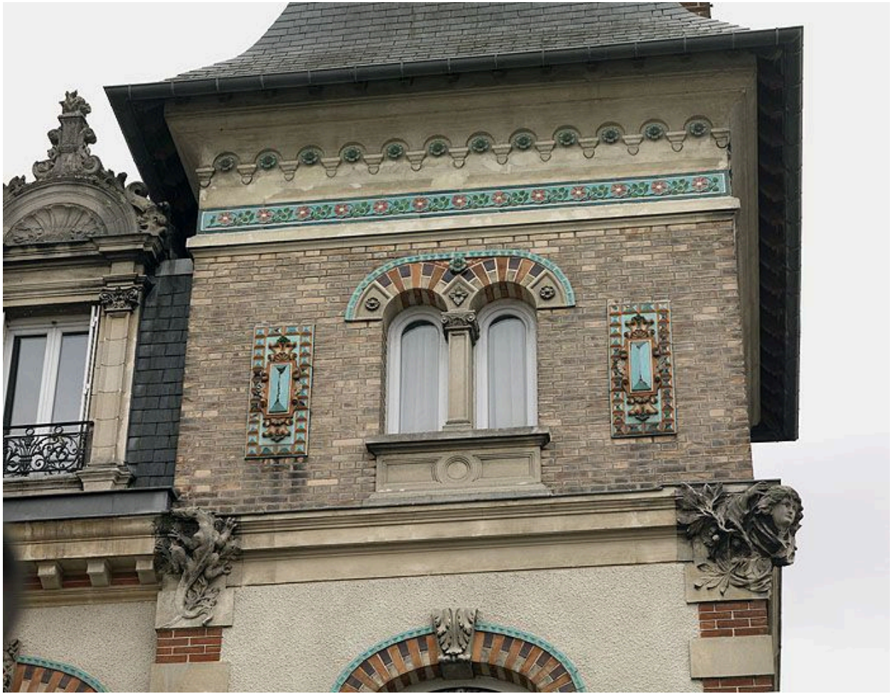
Détail du décor de la façade.
