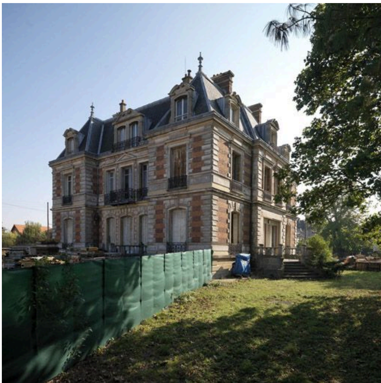
Vue des façades principale (nord-est) et latérale sud.
