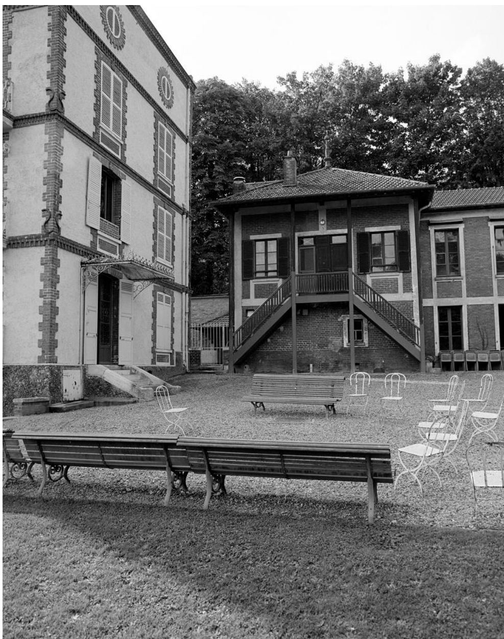
Pavillon Charpentier et, à gauche, la façade nord de la maison.
