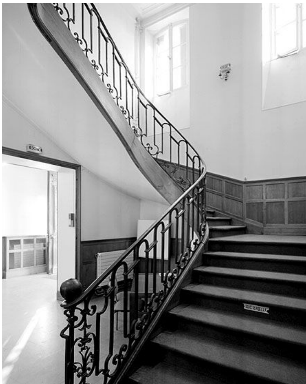
L'escalier d'honneur, vu depuis le bas.
