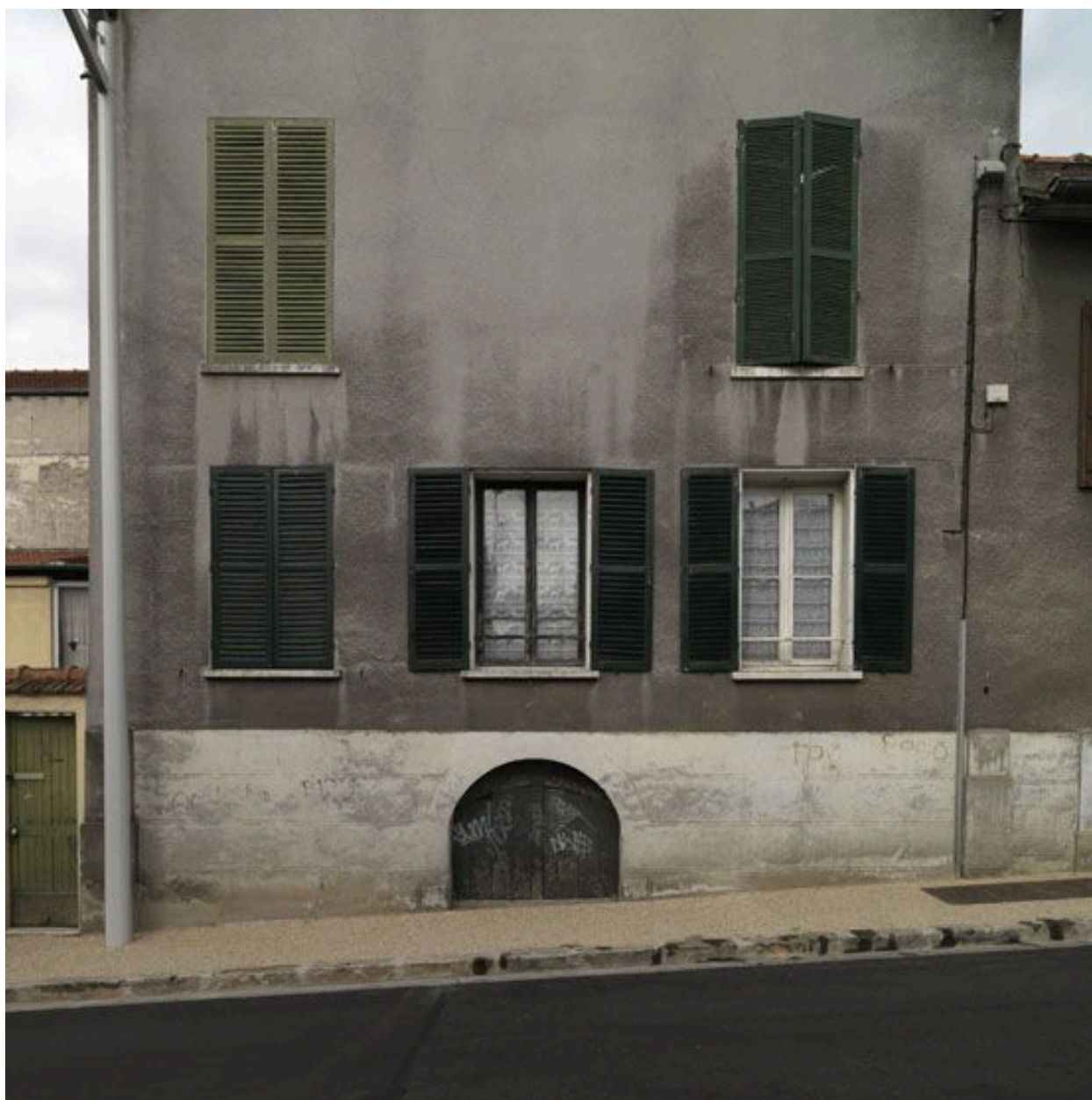
Chanteloup-les-Vignes. Accès extérieur aux caves, rue du Général Leclerc.
