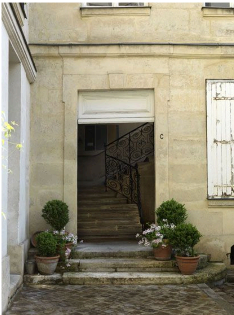
La porte desservant l'escalier à rampe de fer.
