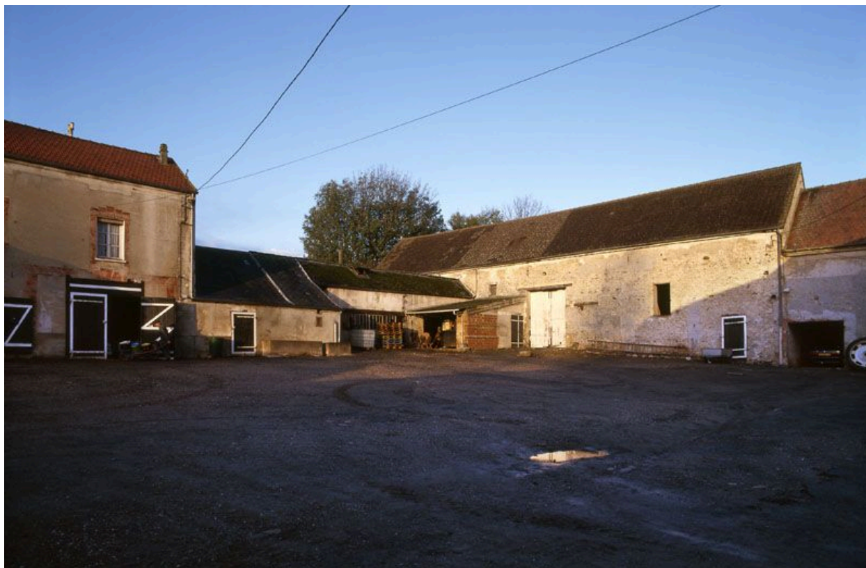
Vue de l'angle nord ouest de la cour.
