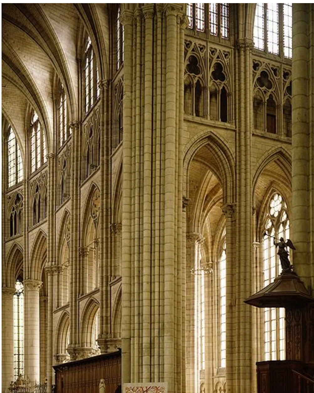
Elévation sud du chœur et bras sud du transept.
