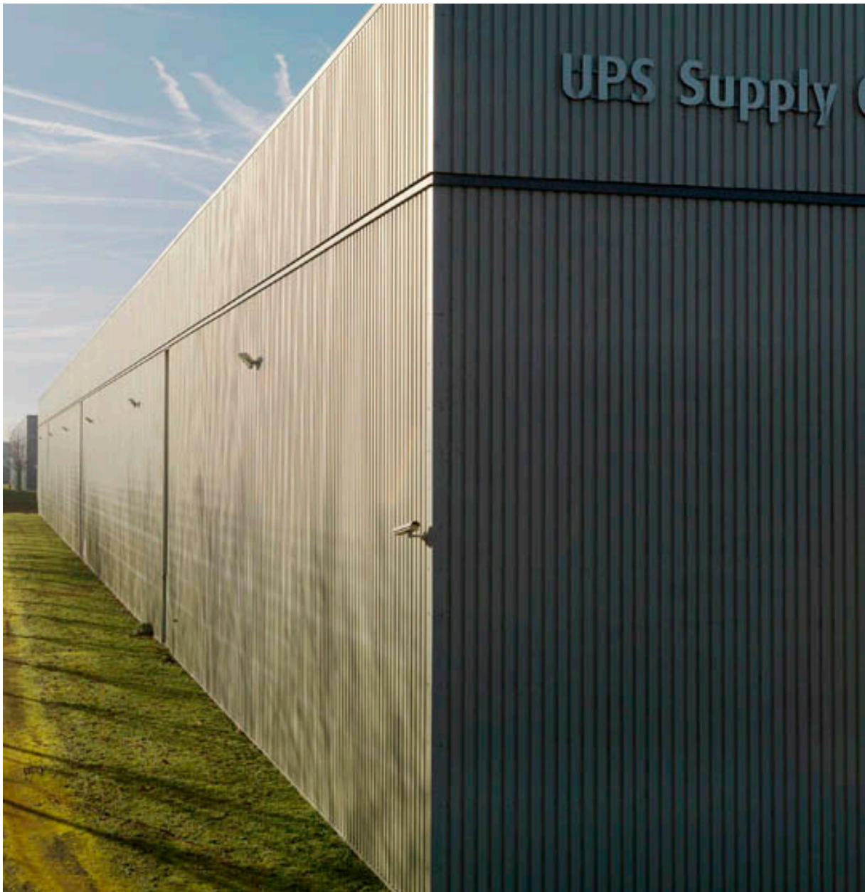
Survilliers. ZI de la Porte des Champs. Entrepôt de l'entreprise UPS.
