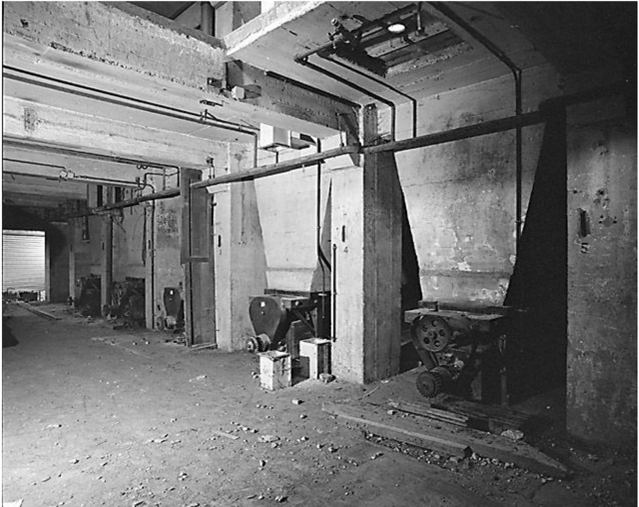
Partie magasin à farine. Au rez-de-chaussée, les trémies des chambres à farine longent le quai de chargement. A gauche, hors champ, la base du toboggan hélicoïdal de manutention.
