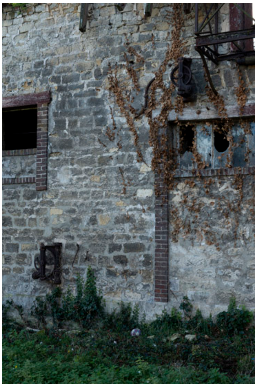
Vestige de mécanisme pour hisser les sacs.
