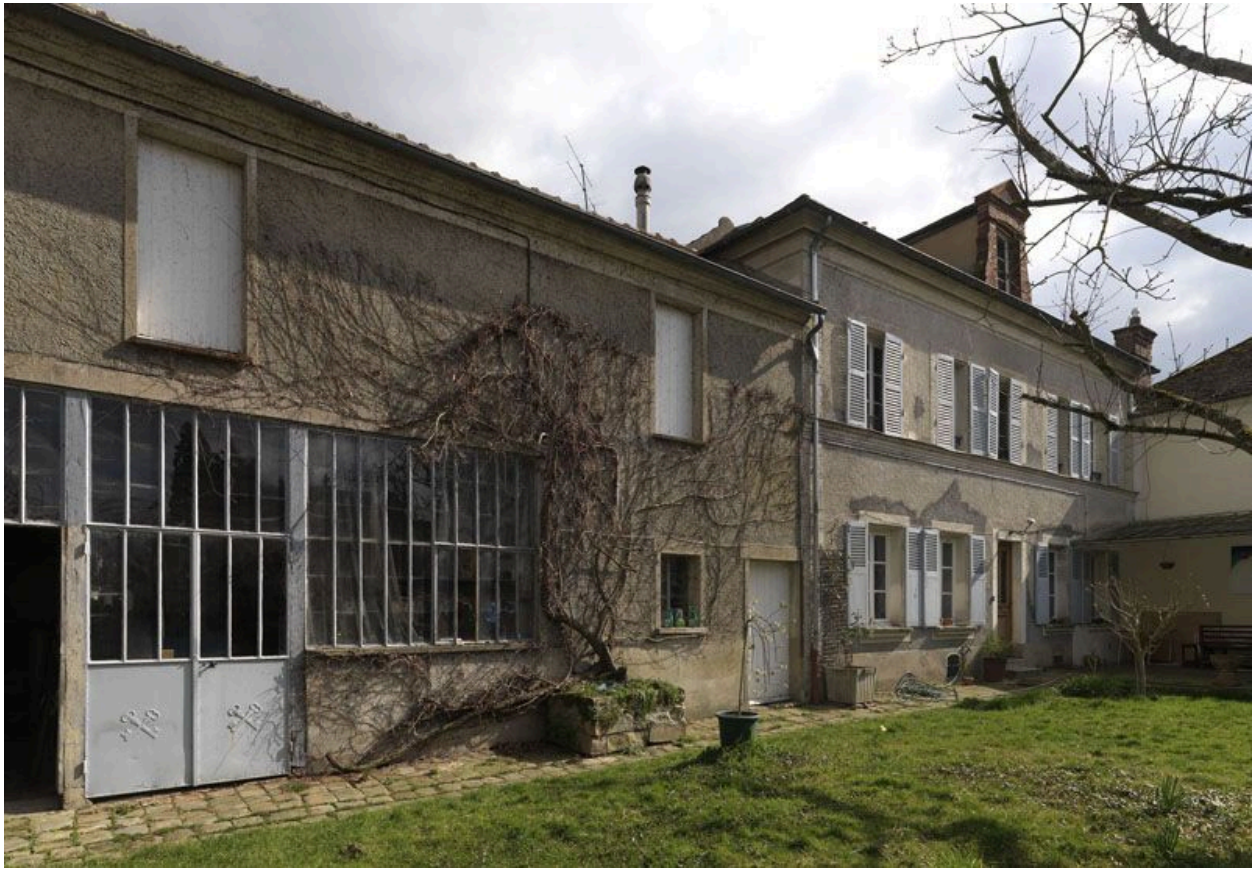
Vue générale de l'atelier et de la maison d'habitation.
