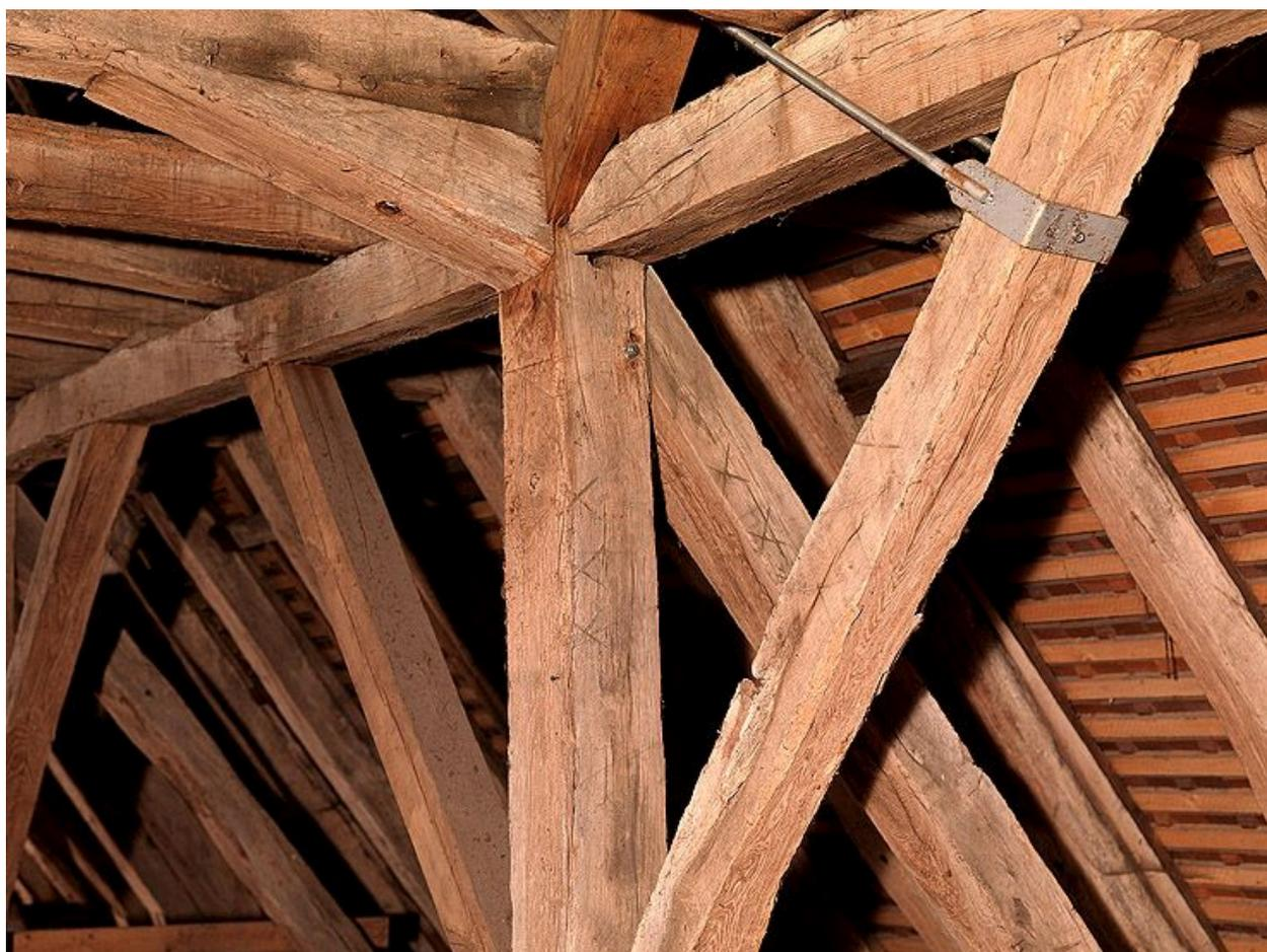
Détail de la charpente du choeur : marques d'assemblage sur la ferme maîtresse "XXX", sur le poteau et la contrefiche (côté nord). Voir aussi cliché 20097700006NUC4A.
