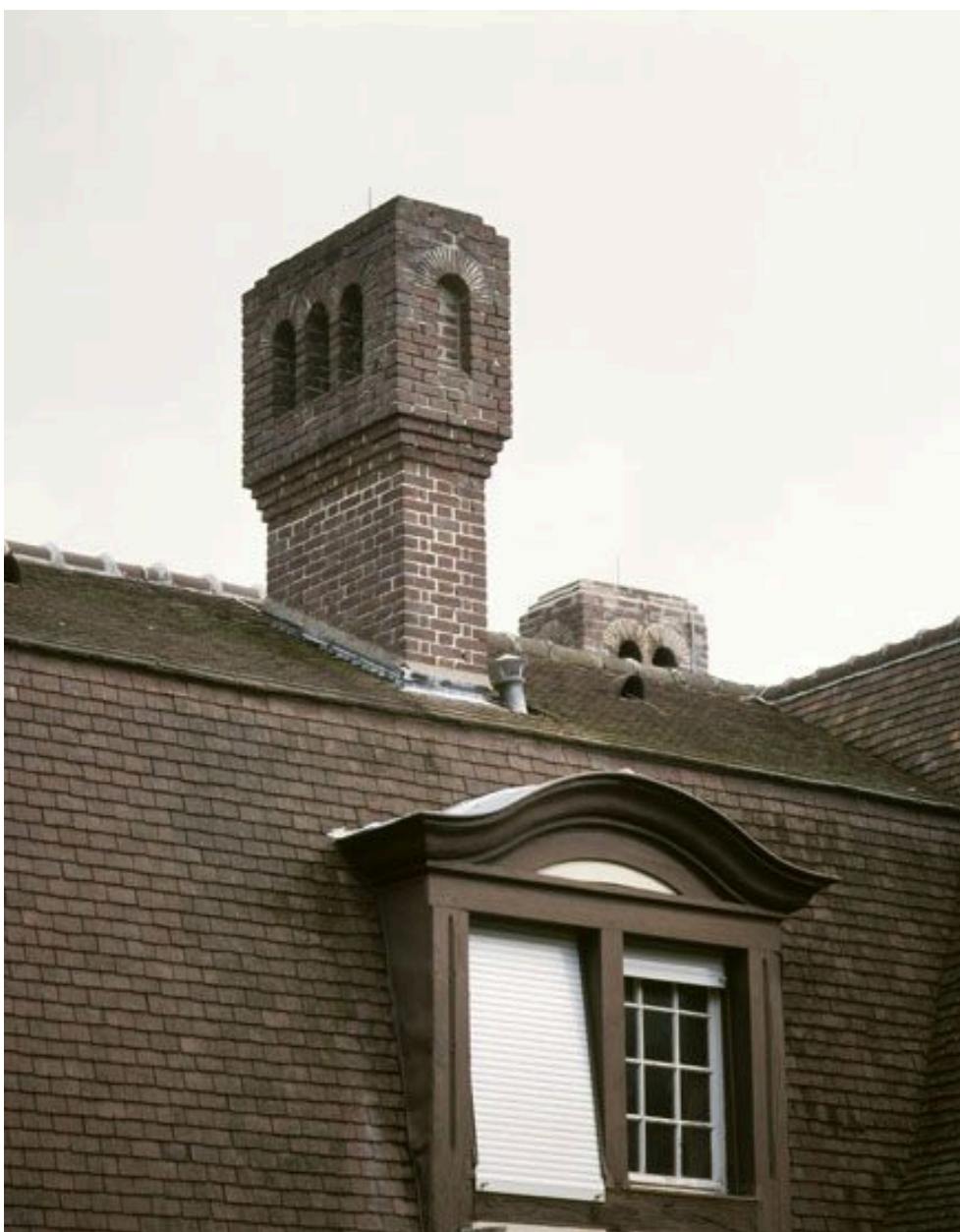
Détail d'une cheminée.
