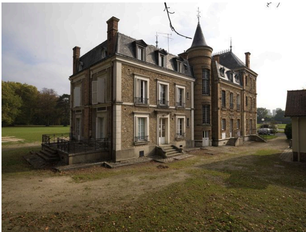
Vue d'ensemble, côté sud-ouest.
