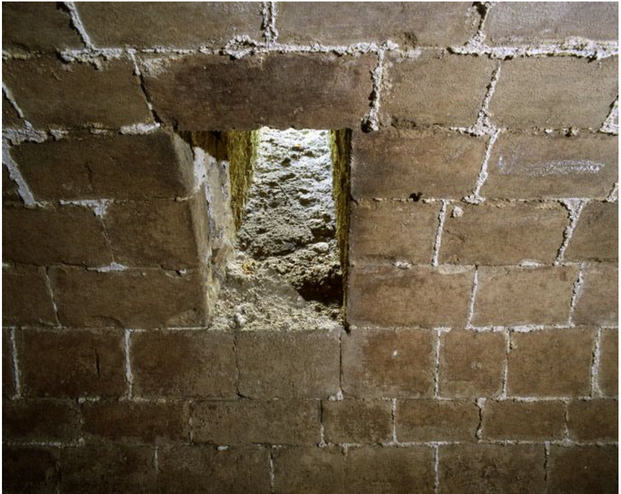
La cave : détail d'un sopirail.
